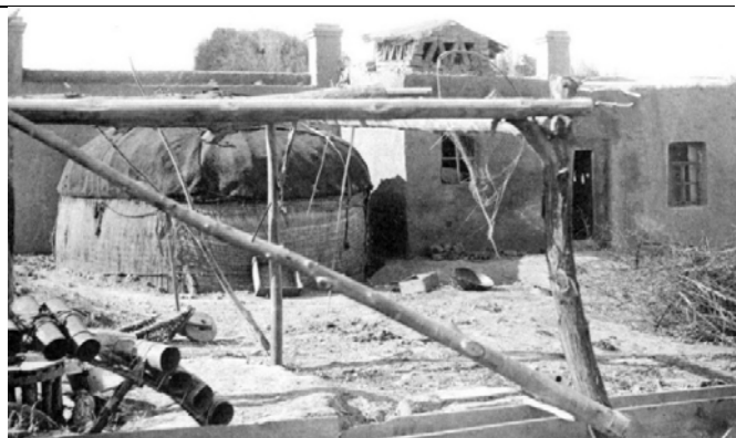
Рис. 10 – Чигирь, установленный на колодце [6, с.40 а].
